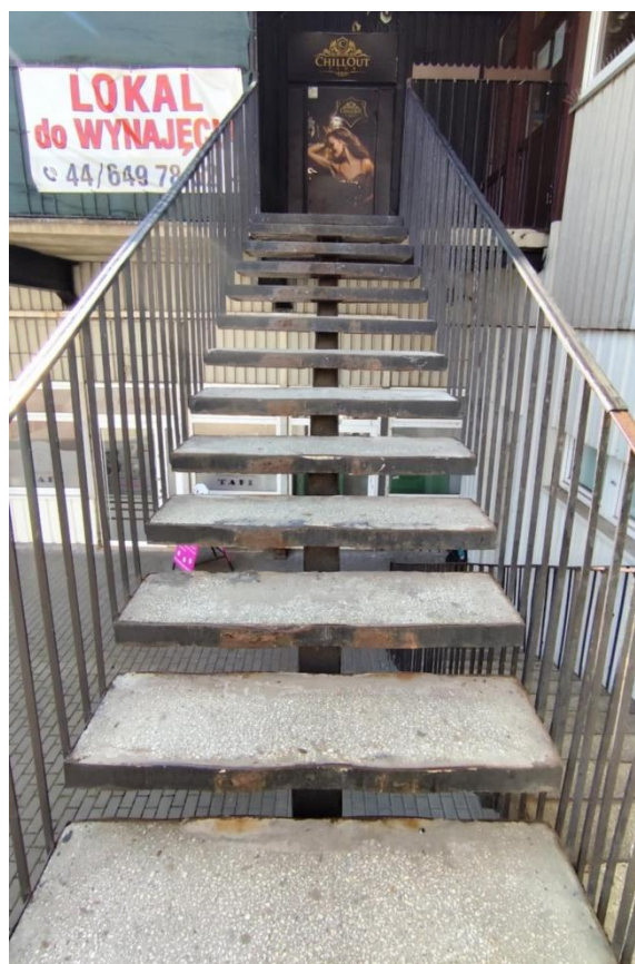
SCHODÓW O KONSTRUKCJI STALOWEJ – WIDOK ZE SPOCZNIKA NA BIEG GÓRNY
