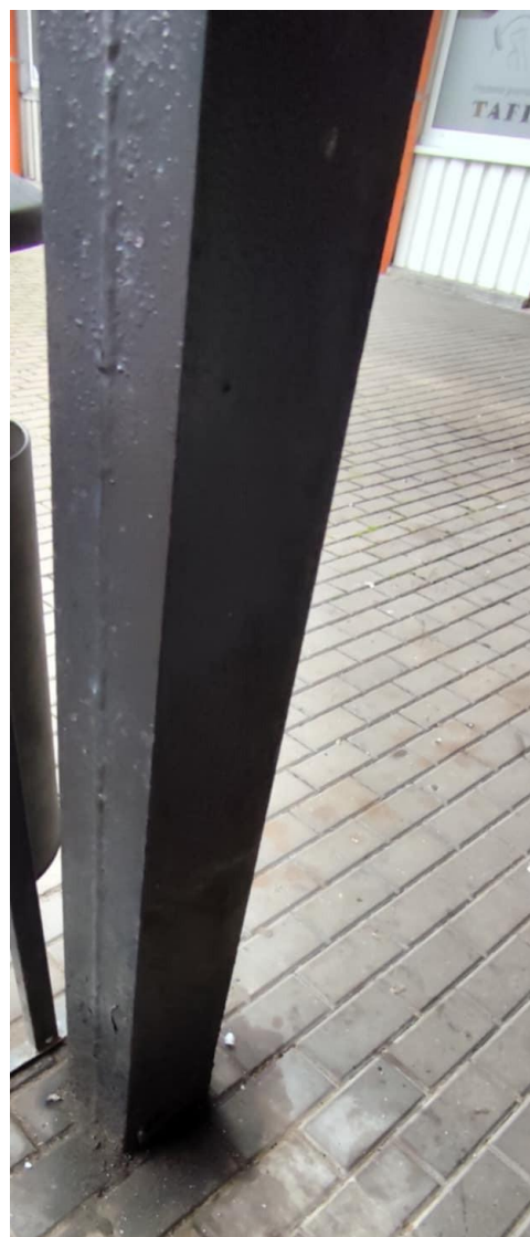
WIDOK POSADOWIENIA SCHODÓW NA SŁUPACH STALOWYCH, RAMIE NOŚNEJ
