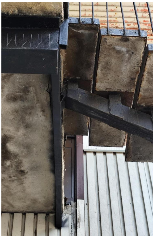
WIDOK POŁĄCZENIA SCHODY – SPOCZNIK GÓRNY
